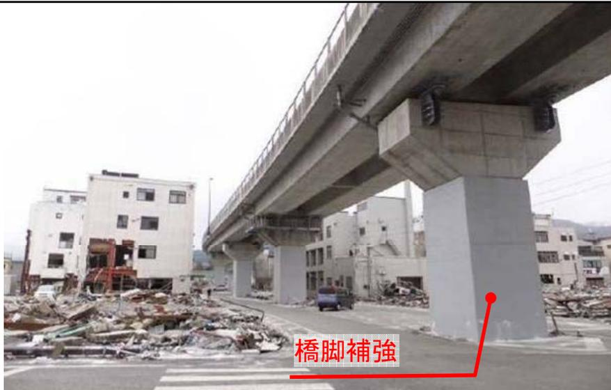
【耐震補強済み(鋼板巻立補強)】
