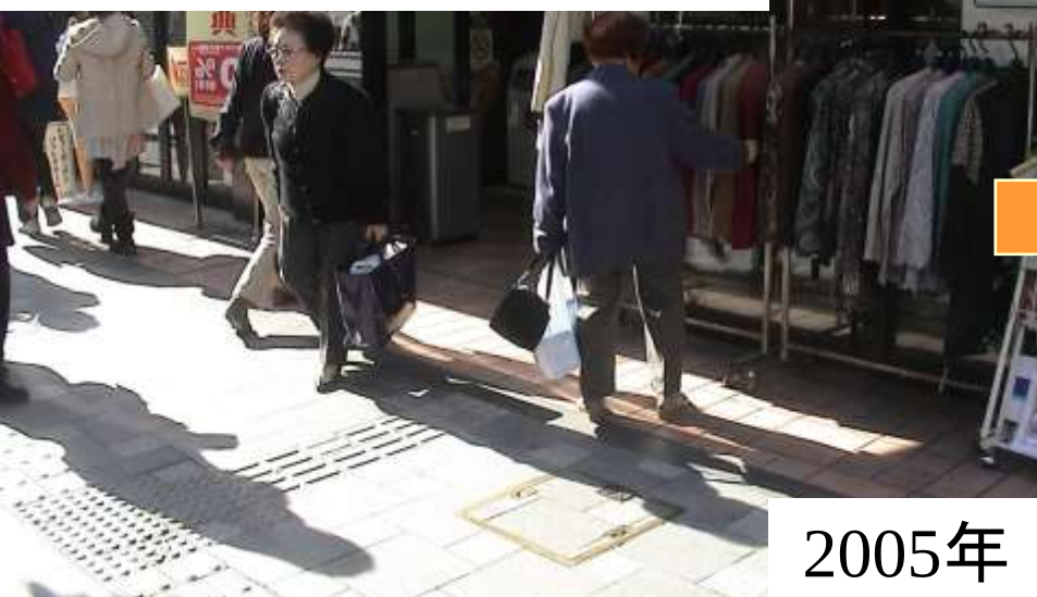
建物入口と整合していない視覚障害者誘導ブロック
