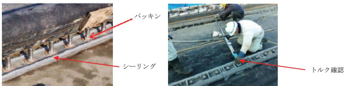
図-31 施工管理状況の例
