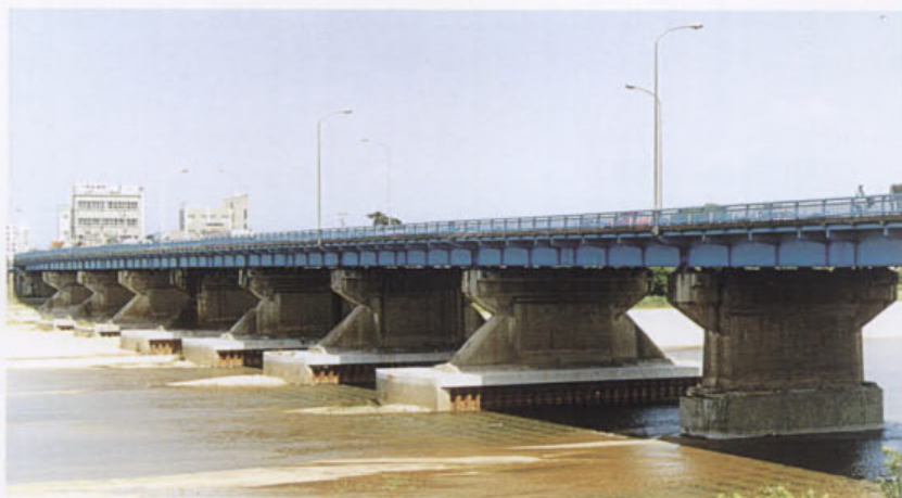
写真 10.1 露出した橋脚基礎の補強事例
