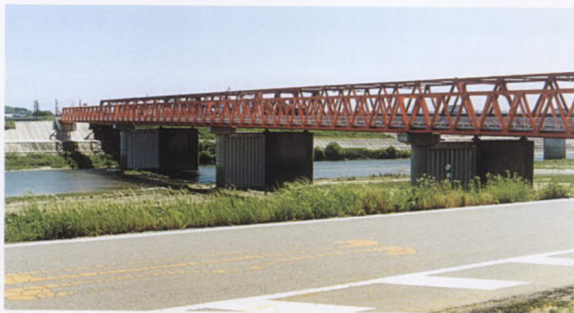
写真 10.3 近接橋の橋脚の一体化による対策例
