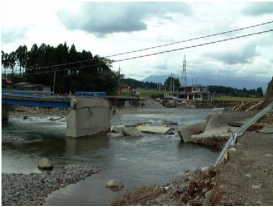
写真 1-3 橋台の洗掘による落橋事例（余笹川での事例）
