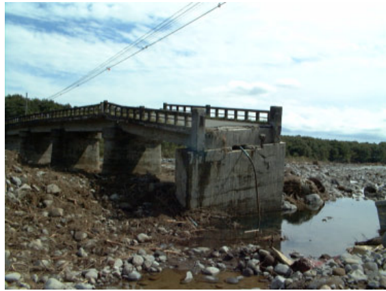
写真 1-3 橋台の洗掘による落橋事例（余笹川での事例）
