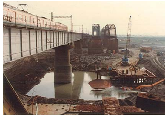
写真 1-4 橋脚周辺の局所洗掘による落橋事例（富士川での事例）
