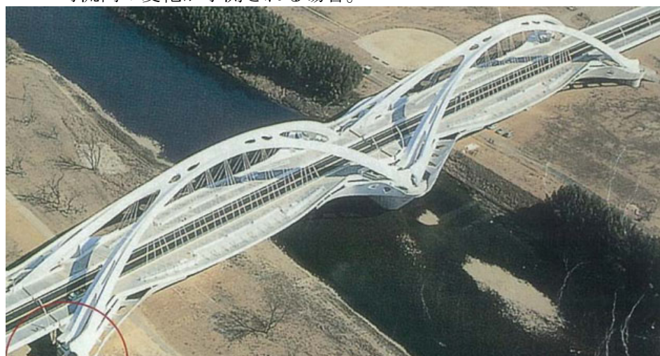
写真 2-1 大規模な橋脚の例（矢作川豊田大橋）
