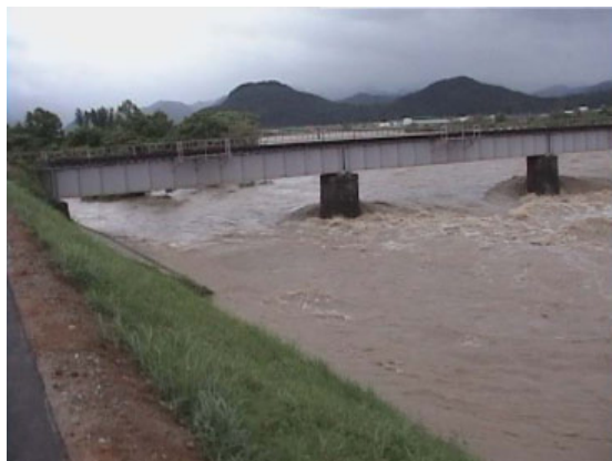
写真 1-1 橋脚による堰上げと迂回流の例（阿賀川での事例）
