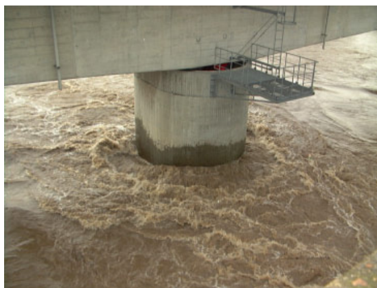
写真 1-2 橋脚周辺での複雑な流況の例（小貝川での事例）
