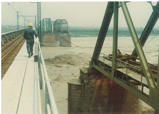
写真 1-4 橋脚周辺の局所洗掘による落橋事例（富士川での事例）
