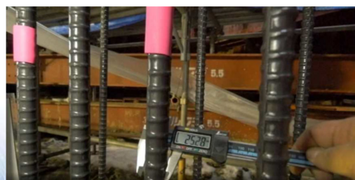
記録映像(鉄筋ピッチ、鉄筋径の確認)
