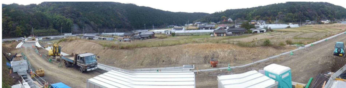
固定カメラから撮影した現場状況
