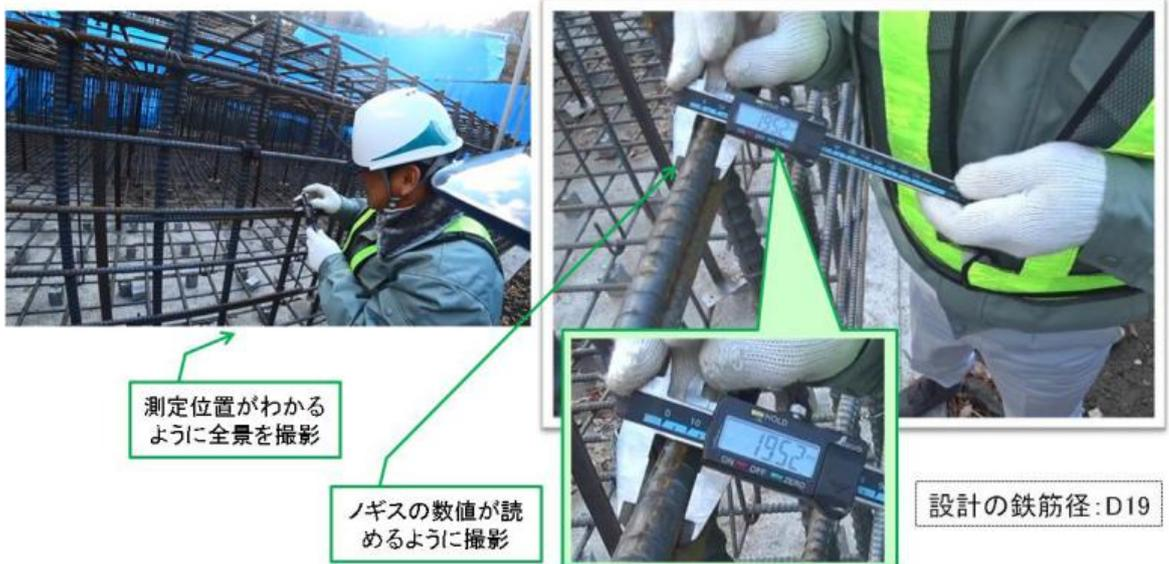
写真 鉄筋径の確認映像
