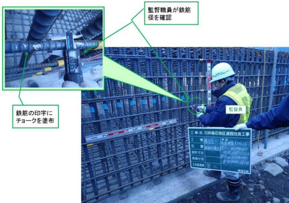
写真 鉄筋径の段階確認の様子
