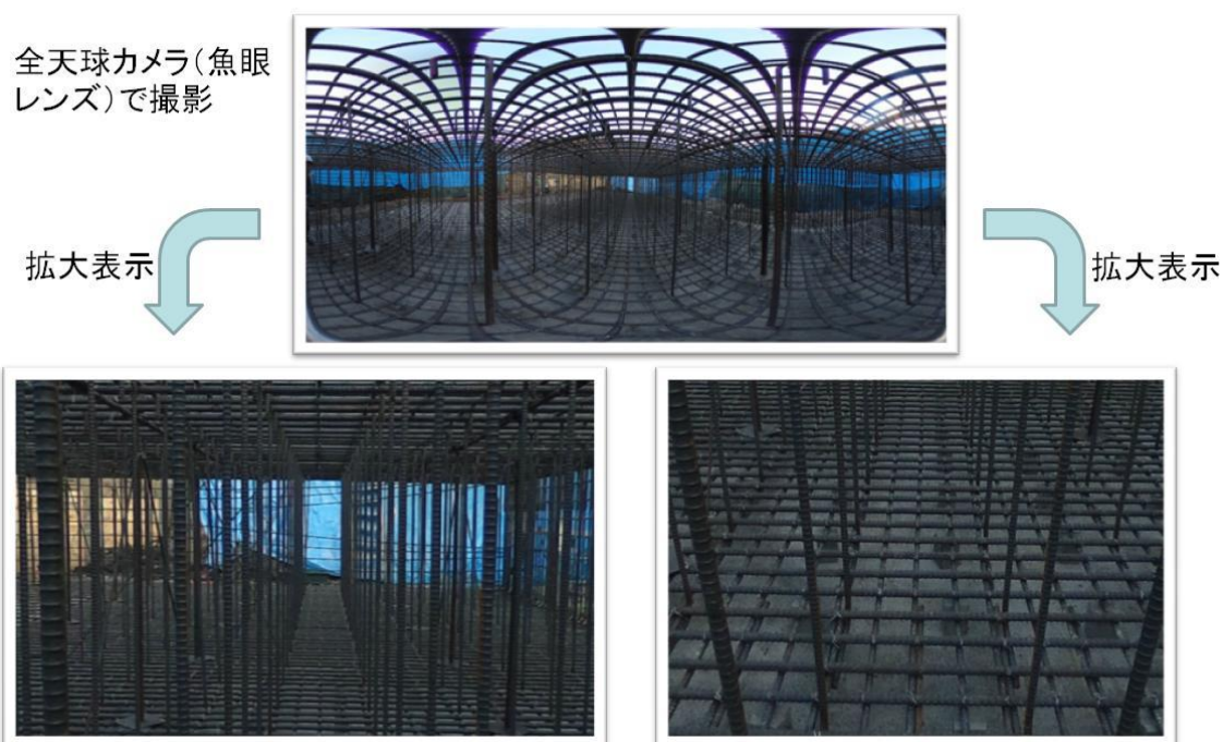
写真 全天球カメラにより撮影した鉄筋内部
