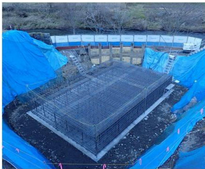
写真 プレ調査の対象とした鉄筋組工全景
