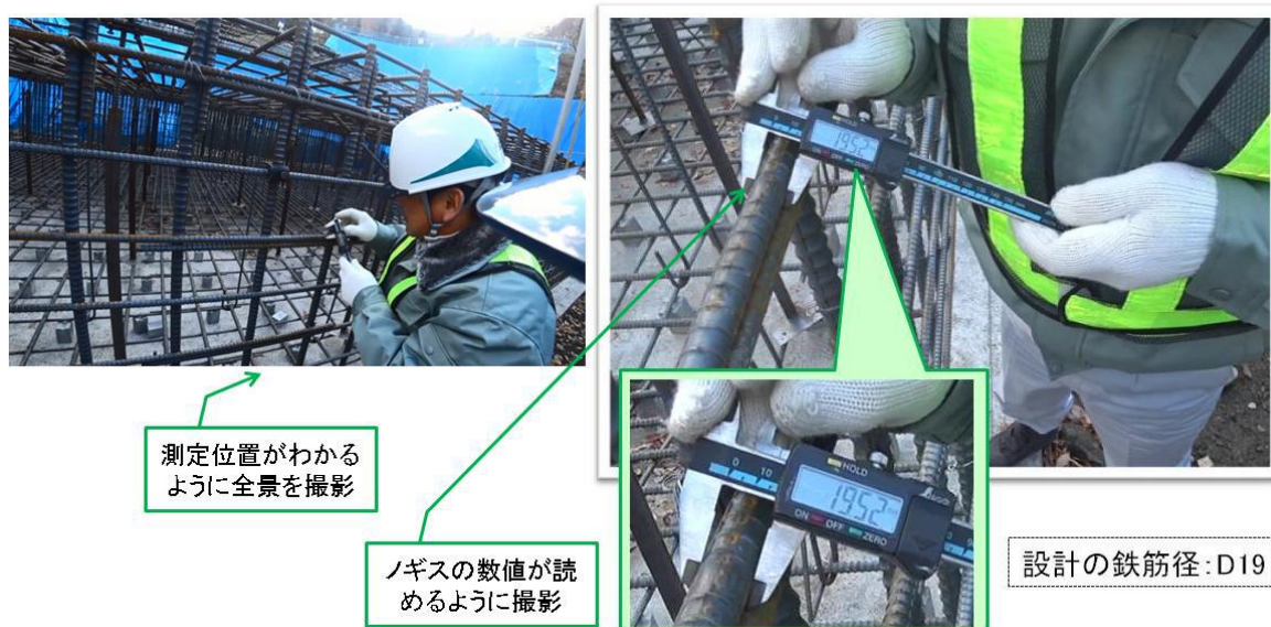
写真 鉄筋径の確認映像
