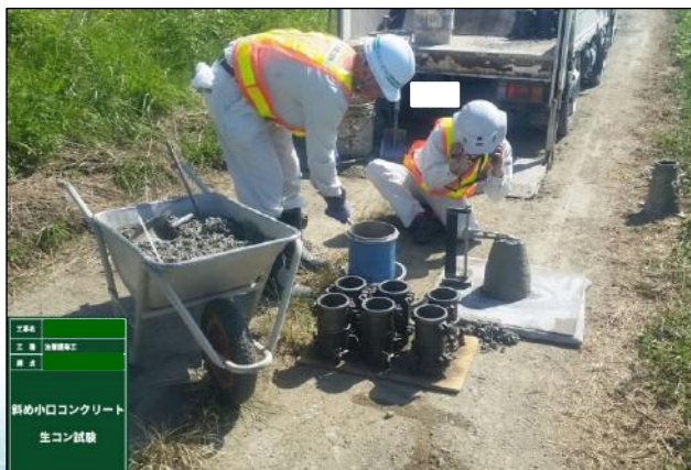
現場側 撮影の状況(生コン性状試験)
