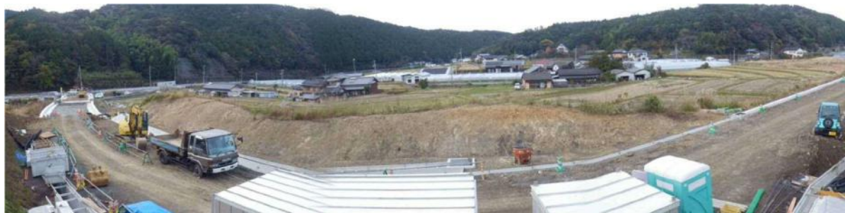
固定カメラから撮影した現場状況
