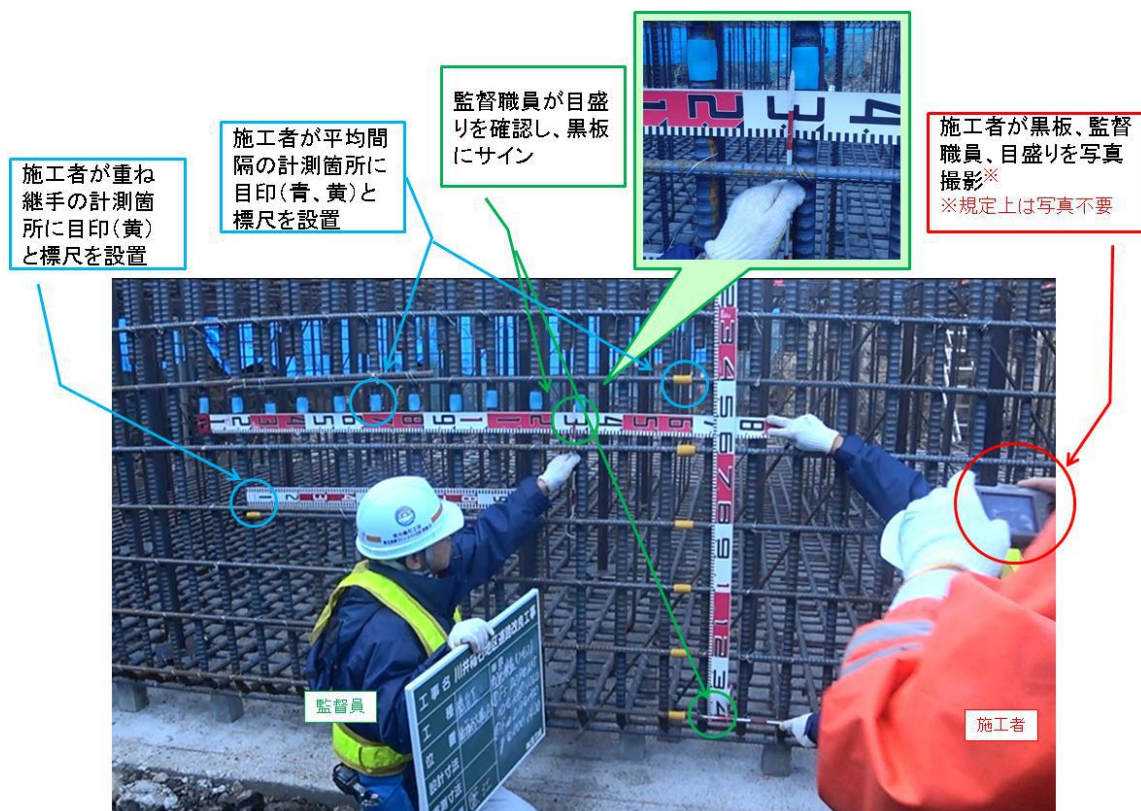
写真 鉄筋間隔・重ね継ぎ手の長さの段階確認の様子
