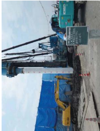
③ 鋼管杭施工
