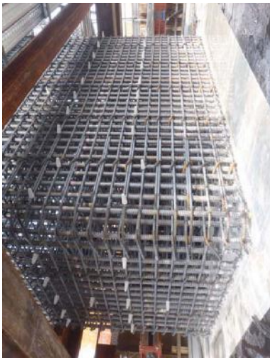
⑧ フーチング・柱鉄筋組立
