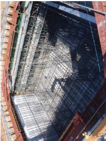
⑦ フーチング・柱鉄筋組立
