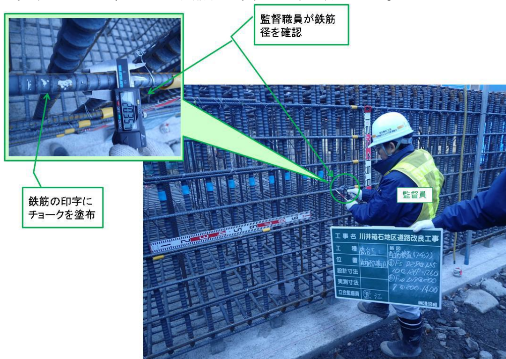
写真 鉄筋径の段階確認の様子
