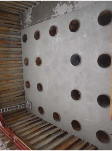
⑥ 均しコンクリート完了(現在)
