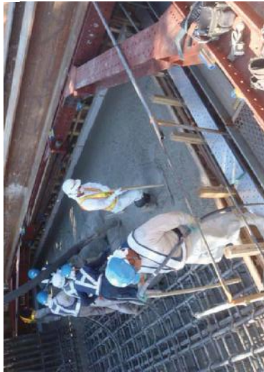
⑨ フーチングコンクリート打設
