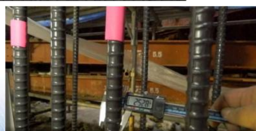
記録映像(鉄筋ピッチ、鉄筋径の確認)
