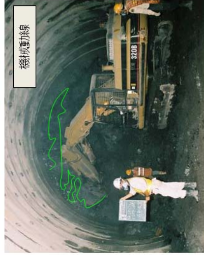
トンネル切羽掘削順序(土質毎)
