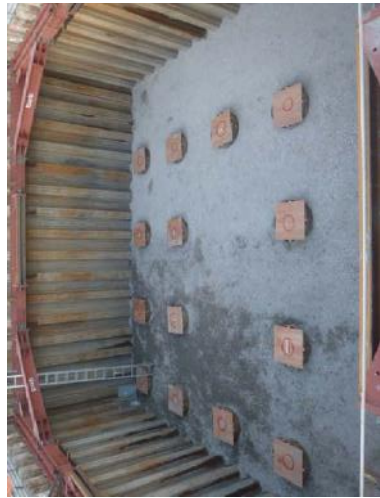
⑤ 基礎砕石完了
