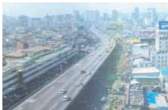
写真－1 撤去前の清溪高架道路と並走する高架下の清溪川路
