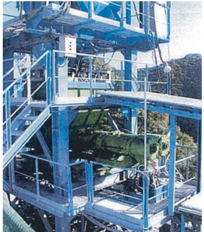
写真-3 スクリューフィーダーの設置状況
