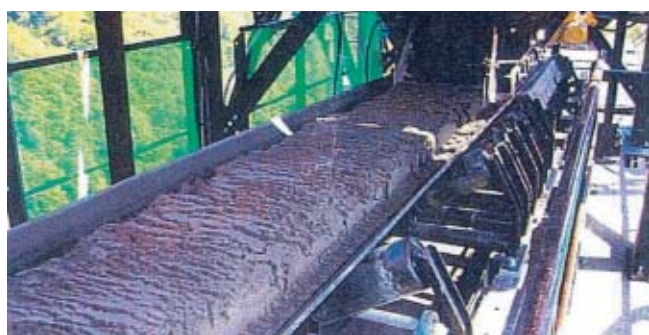
写真-4 木戸ダム モルタル供給装置 (ベルトフィーダ)
