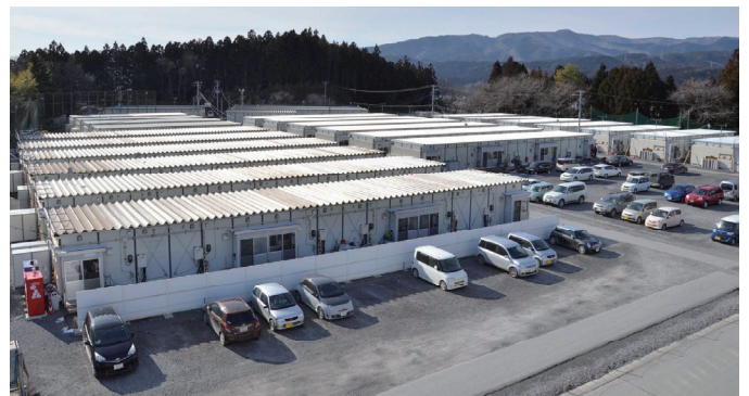
図6 プレハブの仮設住宅
