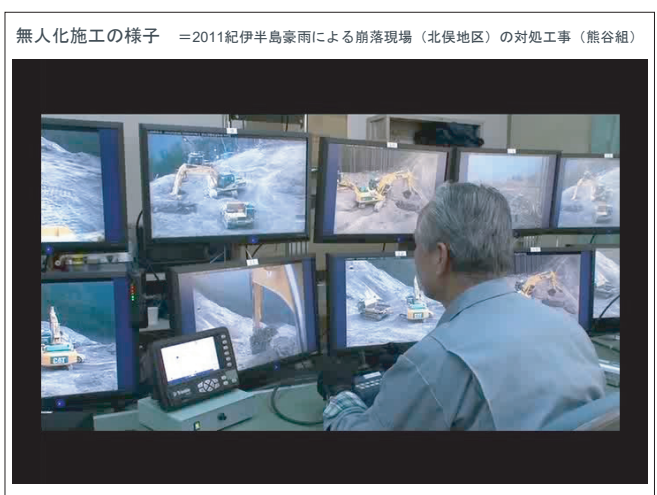
写真 6-1 無人化施工の様子
