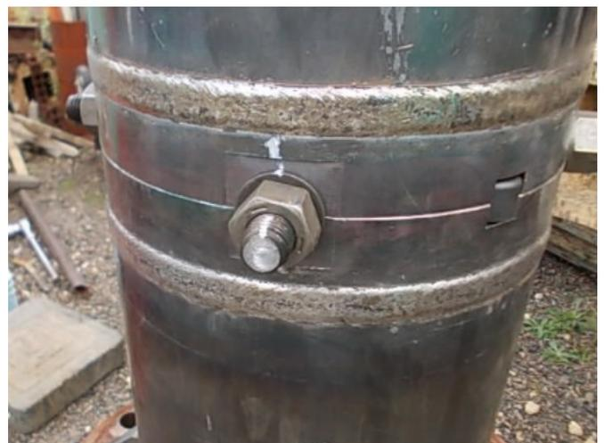
写真 2-3 機械式継手（CCジョイント継手）
