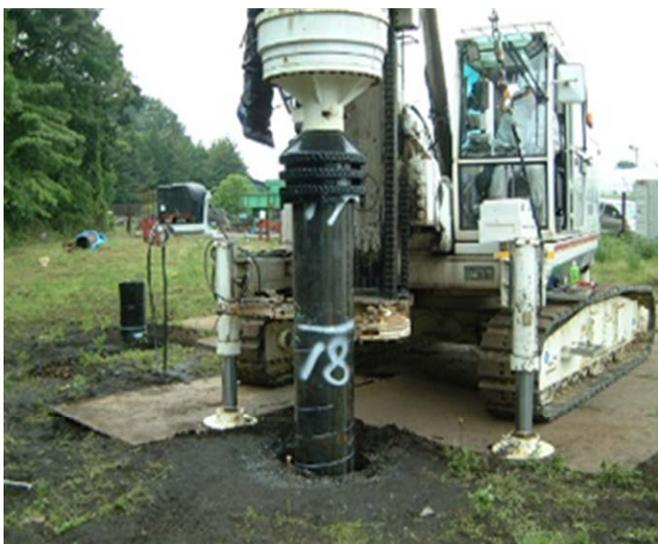
写真 2-1 スクリューパイル EAZET 工法の施工状況
