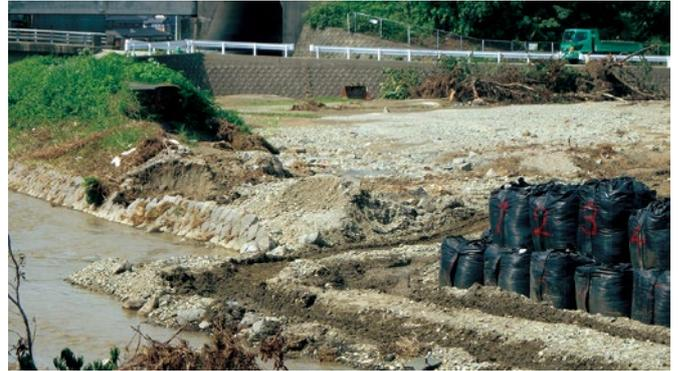
図-8 比良松中学校下流の破堤箇所
