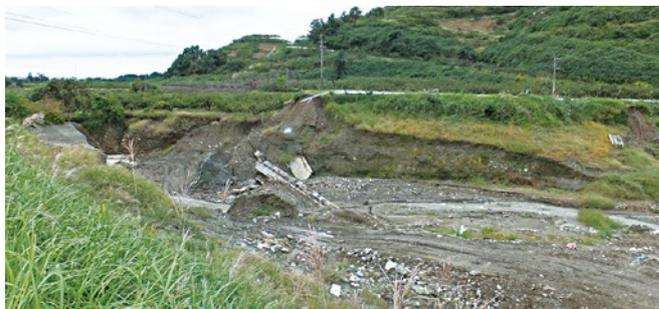
図-14 奈良ヶ谷川 溜池被災及び堰堤崩壊
