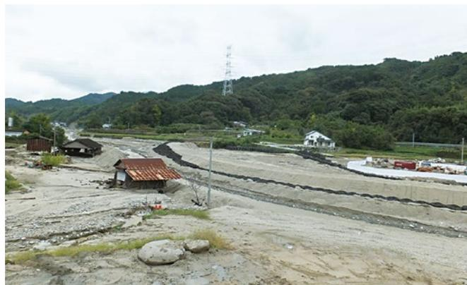
図-21 仮設の輪中堤と土砂止め箇所
