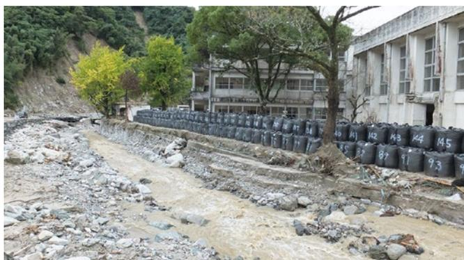
図-13 乙石川の松末小学校付近流路土囊積み
