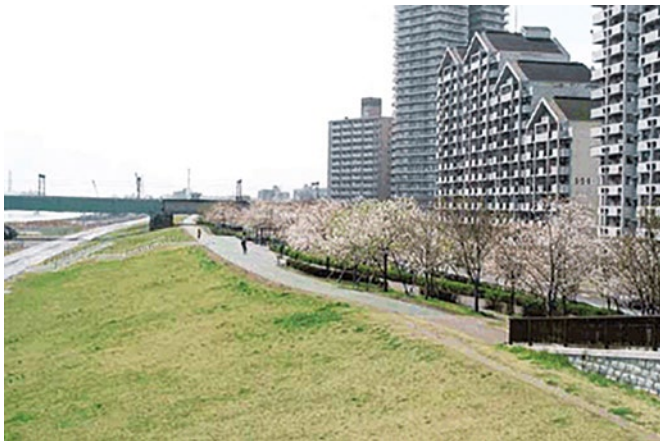
図 荒川のスーパー堤防 (高規格堤防) (出典：国土交通省ホームページ)
