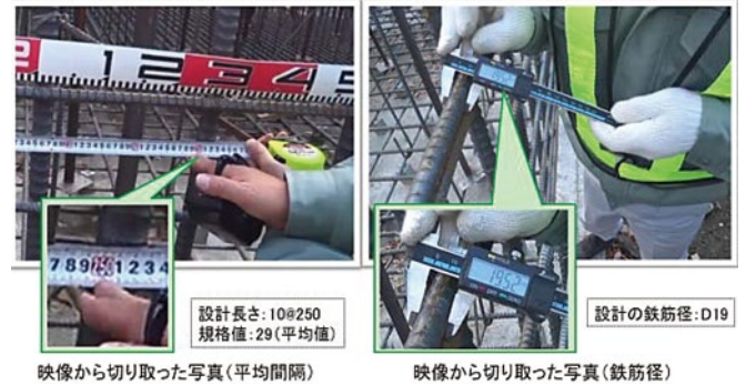
図-4 鉄筋組立工における現場映像の例 (映像提供: 株式会社浅沼組)
