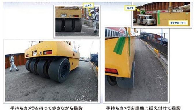
図-5 下層路盤工における現場映像の例 (映像提供: 可児建設(株))
