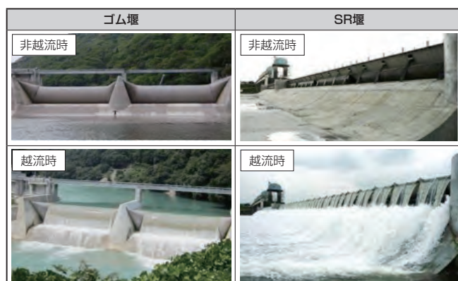
写真1 ゴム堰とSR堰の例
