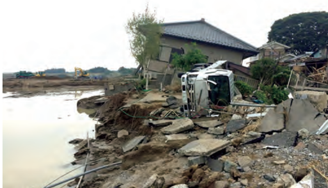
鬼怒川破堤口付近の様子
