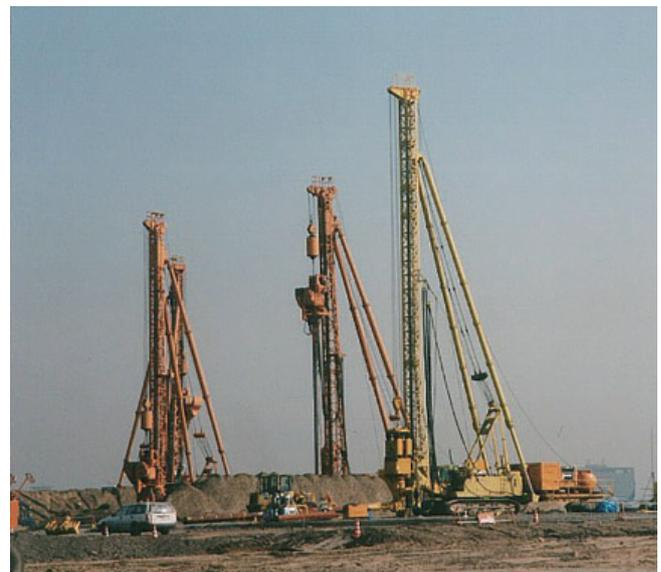
写真1 振動式SCP工法の施工状況
