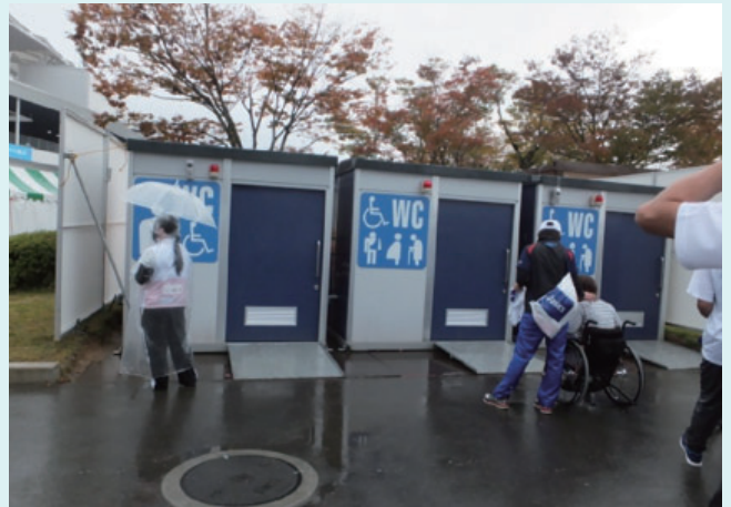
写真5-1 がんばらんば大会で会場に設置された仮設の多機能トイレ （長崎県立総合運動公園陸上競技場）
