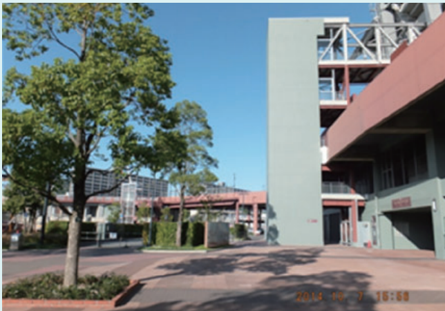
写真4-1 26人乗りのエレベーター（マツダスタジアム） 利用者アンケートから後付けで増設されたもの
