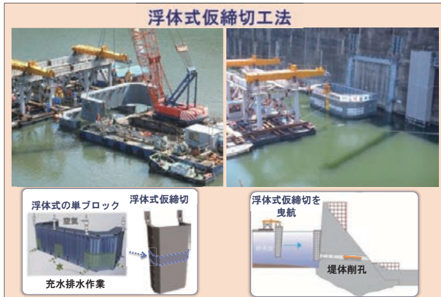
写真-5 浮体式仮締切工法概念図
