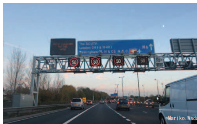
写真3-1 管理型高速道路（M6）で時速50マイル（80km）規制実施
