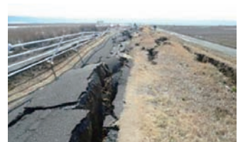
写真2 那珂川支川 溜沼川下石崎地区
