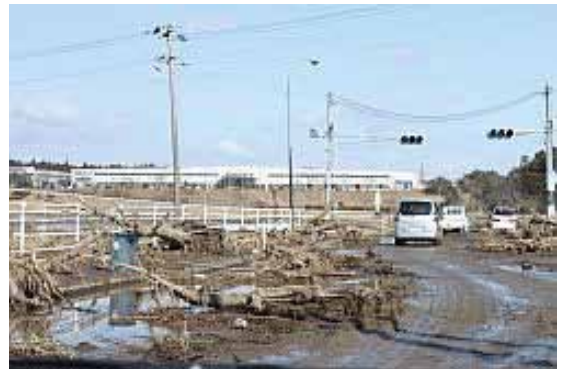
写真4-1 津波による被災状況(国道6号小高区女湯) 出典:南相馬市HP
