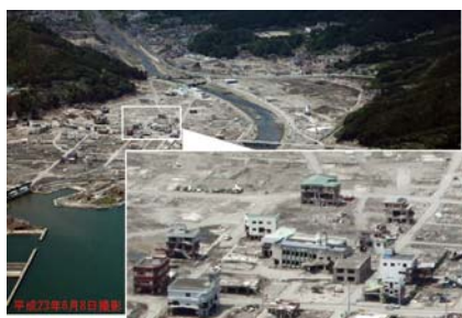
図-18 被災地域の斜め写真
