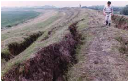
写真1 吉田川堤防（1978年宮城県沖地震） 東北地建提供
