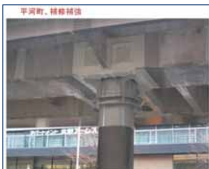
写真-3 補修補強されたピア
