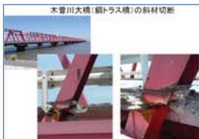
写真-4 木曾川大橋の斜材切断
