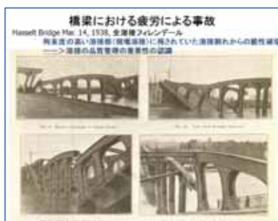
写真-1 橋梁における疲労による事故
