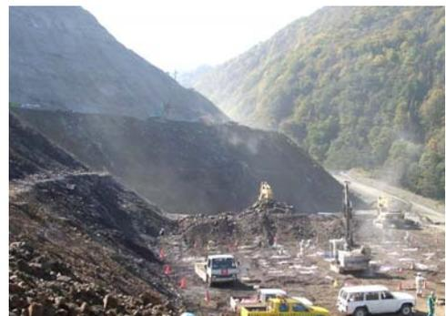
(3) 材料採取（フィルダムのロック材採取）
