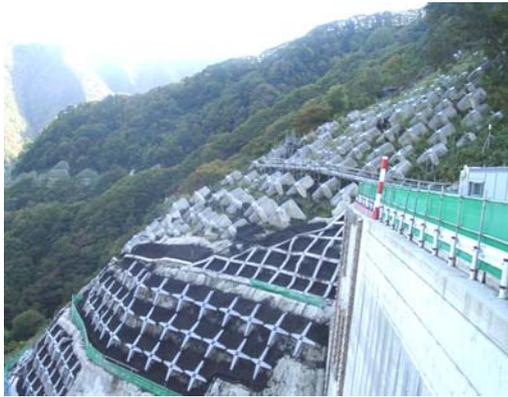
(2) アンカー工による長大化抑制と落石対策 (ダムサイト)
