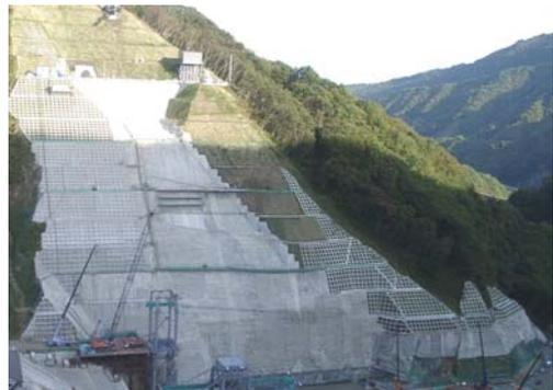
(2) 構造物基礎掘削（ダムのアバット部）
