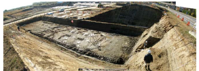
図-2 堤防の開削調査（信濃川）
