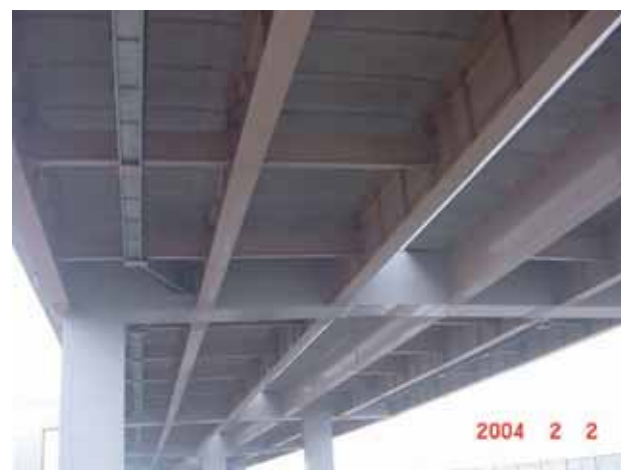
図-8 波形ウエブと少数主桁 (国総研提供)
