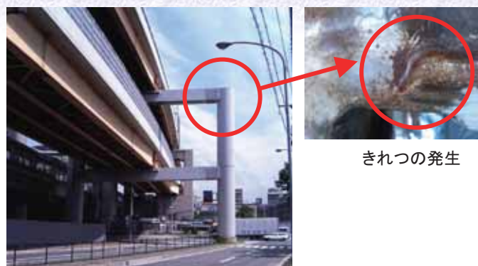
図-9 鋼製橋脚隅角部の溶接 (国総研提供)
