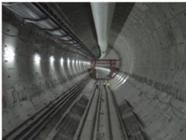
写真-5 掘進が完了した南工区トンネル内
