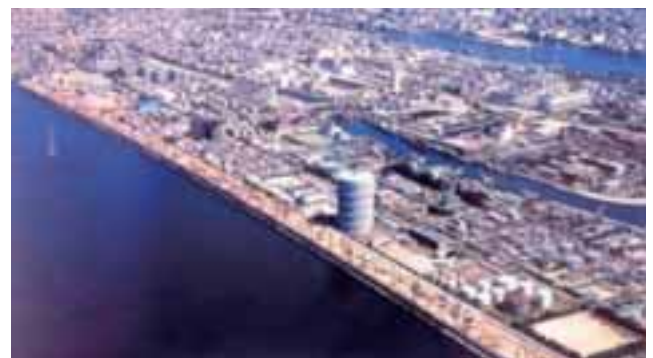
図-3 兵庫県南部地震で被災した淀川堤防
