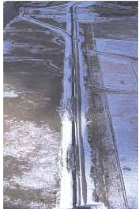
図-6 釧路遊水地左岸堤防の空撮写真
