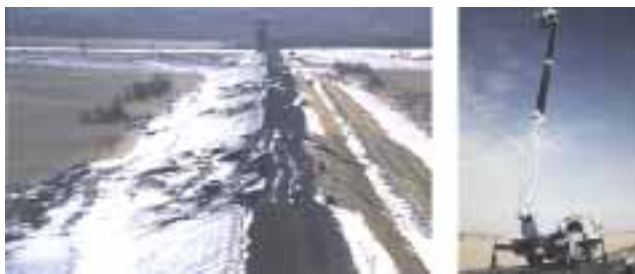
図-9 釧路沖地震による釧路遊水地堤防の被害
