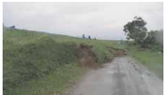
図-16 木間塚堤防の崩壊状況
