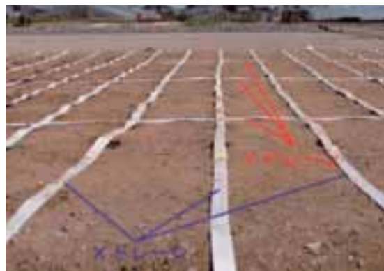
図-2 施工後のネットワークドレーン
