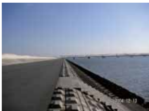
写真-2 木曾川左岸4k 堤外側状況
