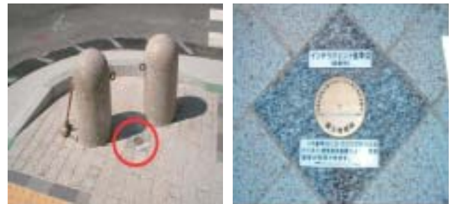
写真-13 世界初のインテリジェント基準点 (神戸市)
