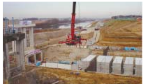
写真-2 大断面の樋門への適用例(施工状況)
