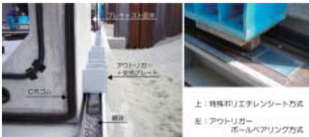
写真-1 底版摩擦低減工法例
