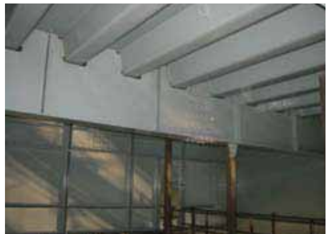
図-1 鋼床版橋梁の例
