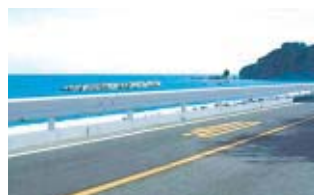
■ 防護柵更新前の状況 (CGによる再現)
