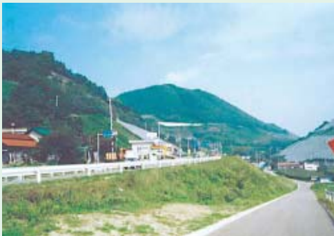
写真 - 3 周辺景観から浮立っている白色の防護柵の例
