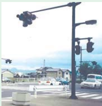
写真 - 7 防護柵と照明・信号柱の色彩が異なっている例
