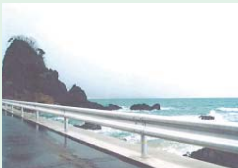
写真 - 5 外部への眺望を阻害している透過性の低い防護柵の例
