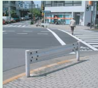
写真 - 2 交差点隅切り部に防護柵が設置されている例
