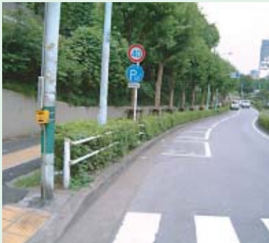
写真 - 1 植樹帯と横断防止柵が二重に設置された例
