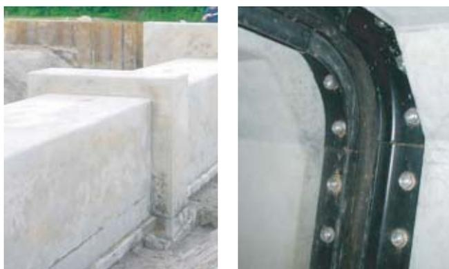
写真-2 カラー継手(左)と可とう継手(右)
