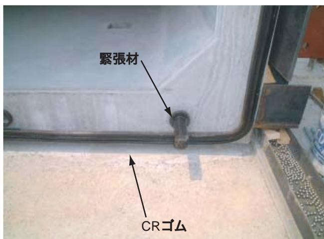
写真-3 弾性接合方式の接合部
