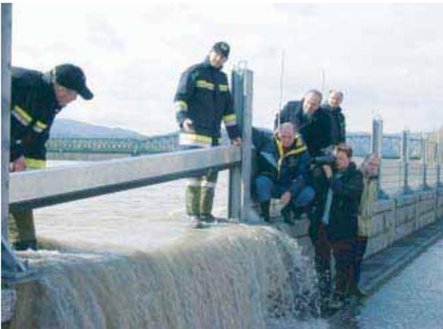
写真 - 3 可搬式の特設堤防、ドナウ川クレムスでの例
