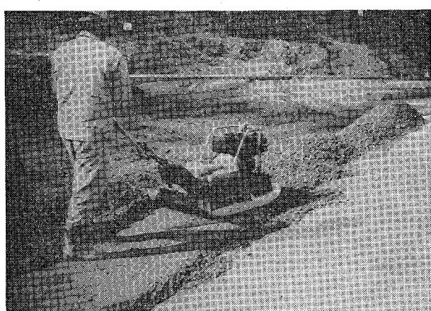
打継部コンクリートをビブロプレート(DVU-1500)で締め固める
