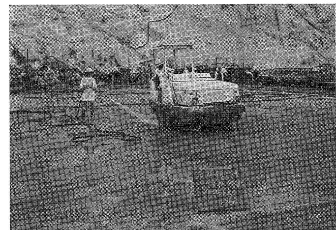
図 5.51 モータースイーパー及びジェット水によるグリーンカット (B種配合)
