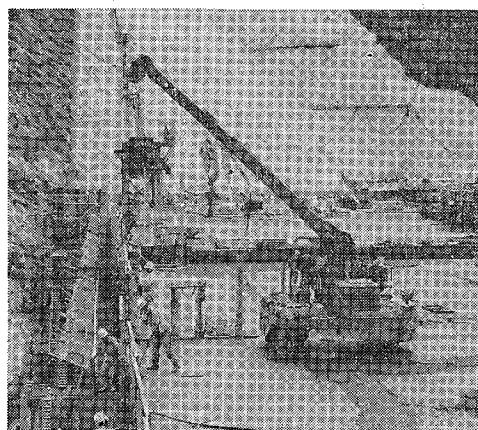
図 5.35 型枠スライド状況（上流面）
