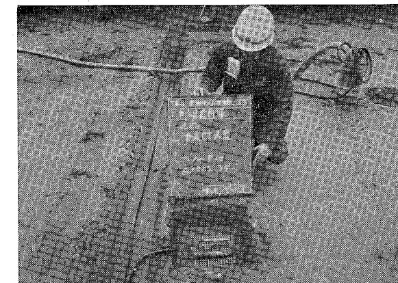
図 5.78 溫度計埋設状況
