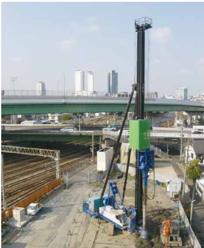
SDP-N工法の施工状況
