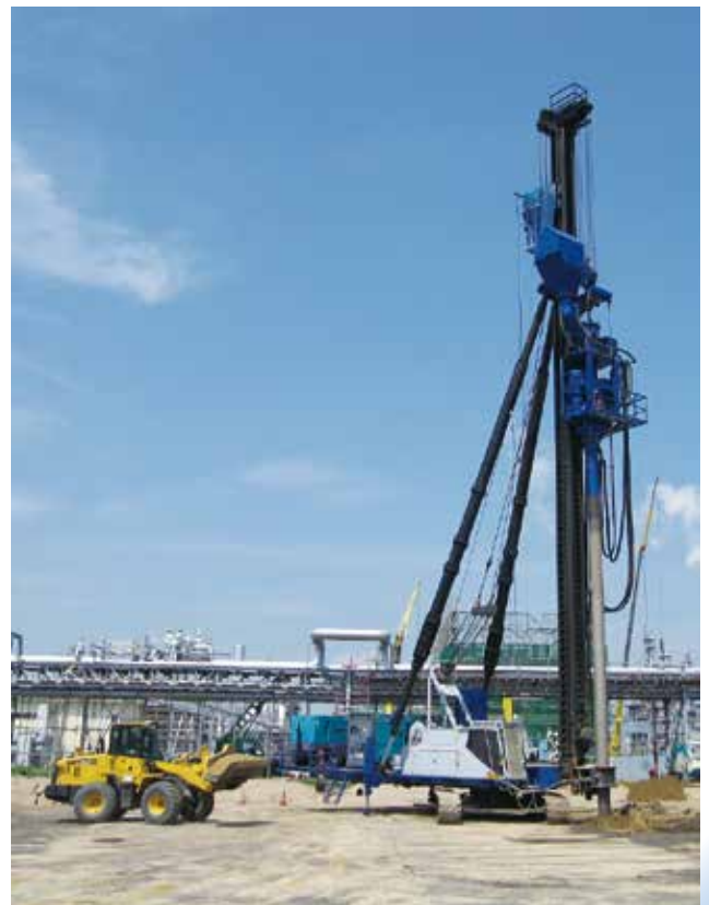
SDP-N工法の施工機械全景
