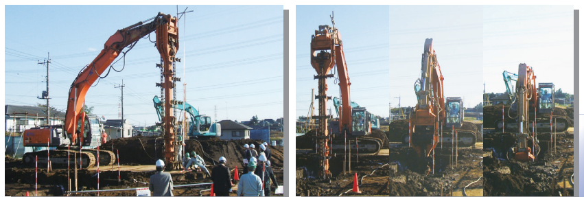
施工時の機械高さの測定状況
