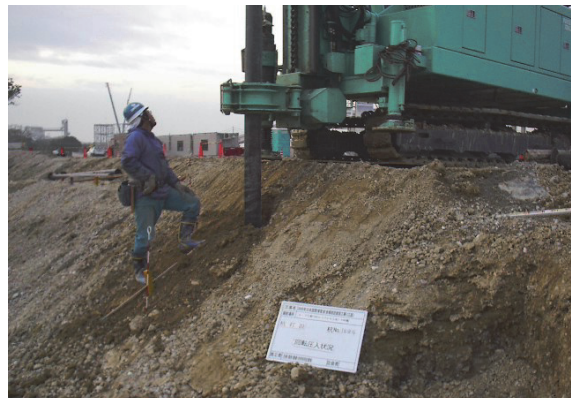
斜面での施工
