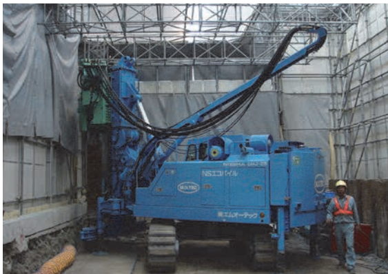
上空制限下での施工
