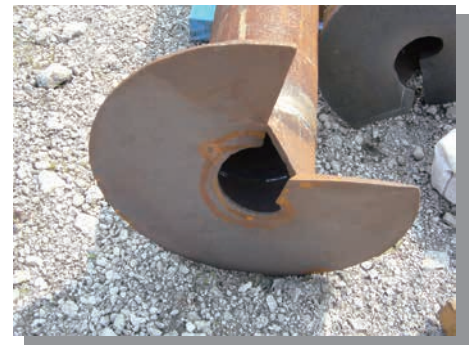
杭先端部(鑄造羽根)
