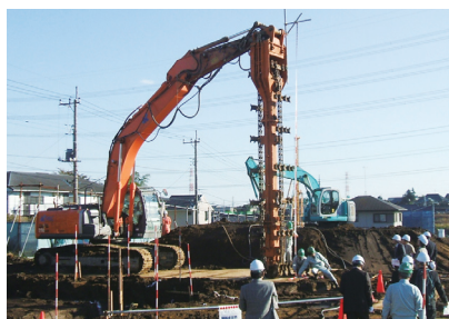
施工時の機械高さの測定状況
