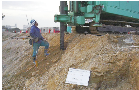
斜面での施工
