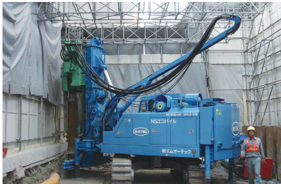
上空制限下での施工
