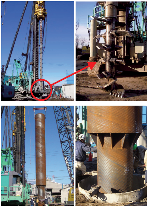
HYSC杭施工状況(拡頭タイプSS)
