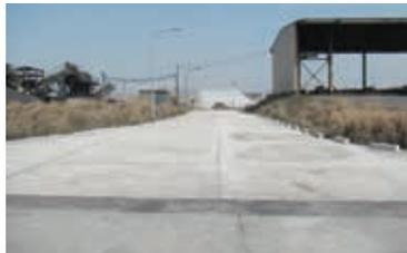
鉄鋼スラグを使用して製造した海水練り舗装コンクリート
