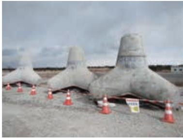
高耐久海水練りコンクリートを使用して製作した消波ブロック
