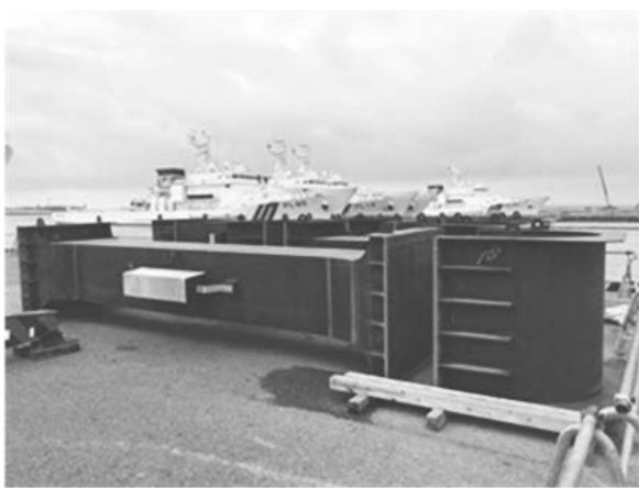
写真－3 石垣港（浜崎地区）巡視船係留施設改良工事施工状況
