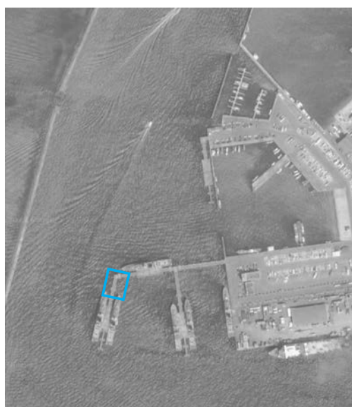
写真－4 石垣港（浜崎地区）巡視船係留施設改良工事全景
