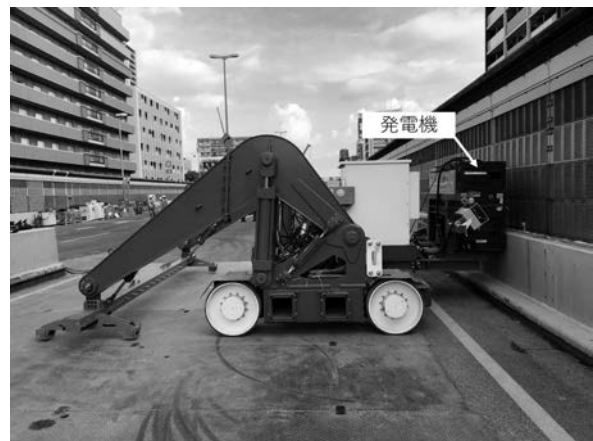
写真－6 発電機搭載
