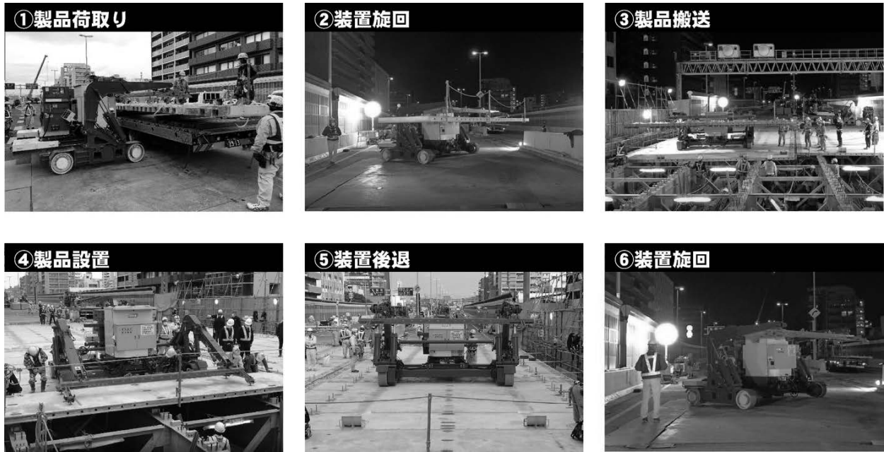
写真－5 施工工程
