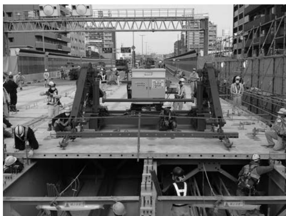
写真－2 床版据え付け
