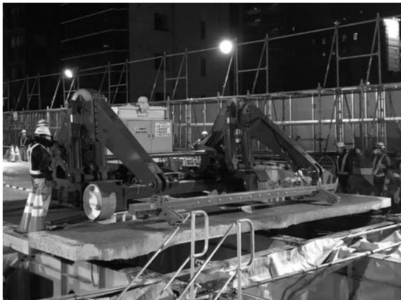
写真-8 既設床版の撤去
