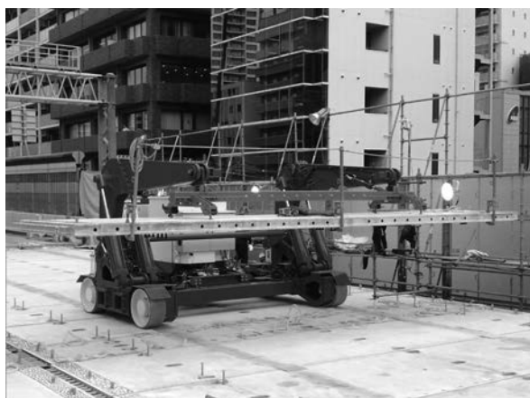
写真－1 床版搬送
